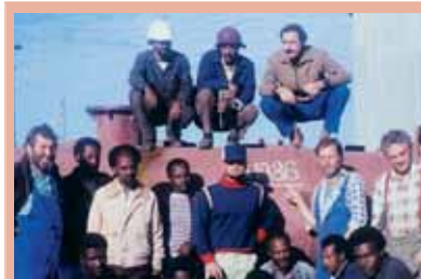
L. Vehner VODNÁ ELEKTRÁREŇ MALKÁ WAKANANA (ETIÓPIA)
